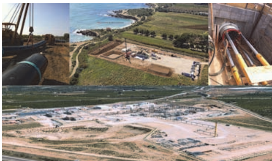
Figura 4. Instalaciones en tierra. Arriba izda.: instalación gasoducto; arriba centro: zona del aterraje del gasoducto; arriba dcha.: microtúnel de paso de la costa. Abajo: obras de la Planta de Operaciones.
