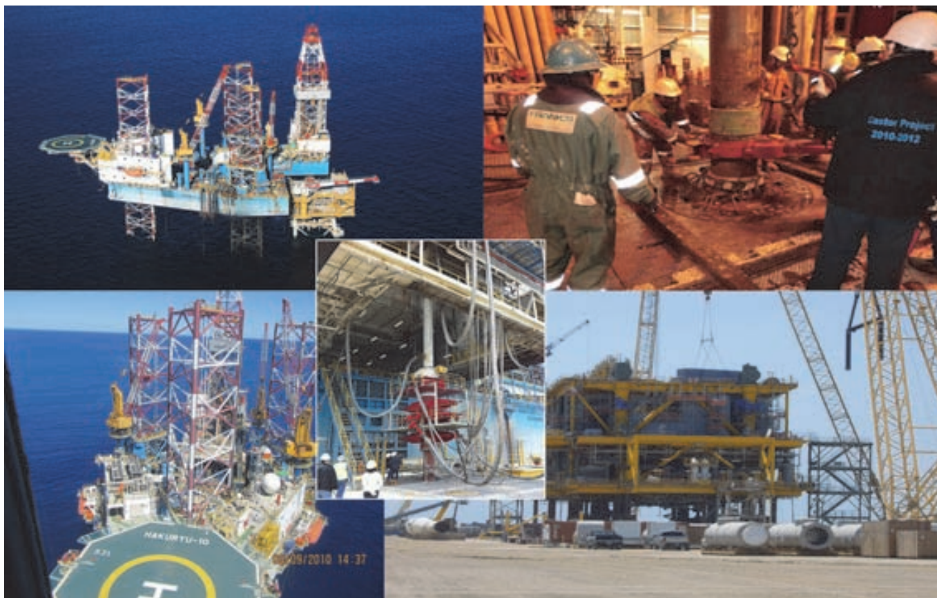
Figura 5. Instalaciones en el mar. Arriba izda.: equipo de perforación tipo jack-up Hakutyu 10 sobre la plataforma de pozos; arriba dcha.: operaciones de entubación de un pozo. Centro: preventor de erupciones bajo la ménsula del equipo de perforación (BOP-Blow Out Preventor). Abajo izda.: vista del equipo de perforación; Abajo dcha: módulos de la plataforma de producción en el astiller.
