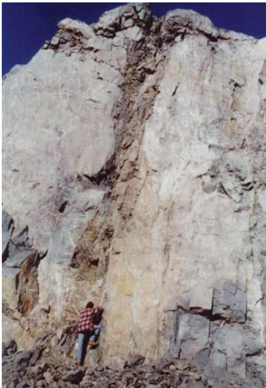
Figura 8. Midiendo orientaciones de fracturas en el frente de cantera.
